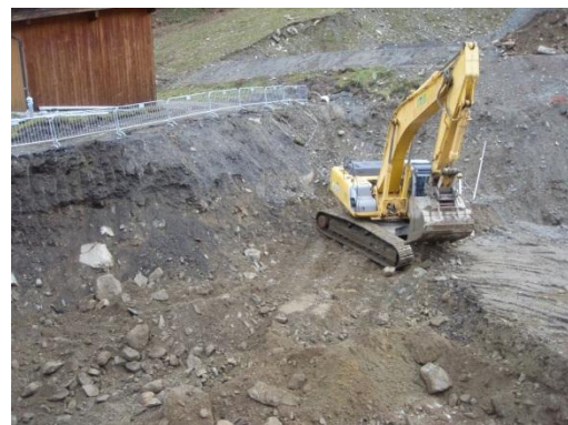
Abbildung 2: Fundamentaushub
