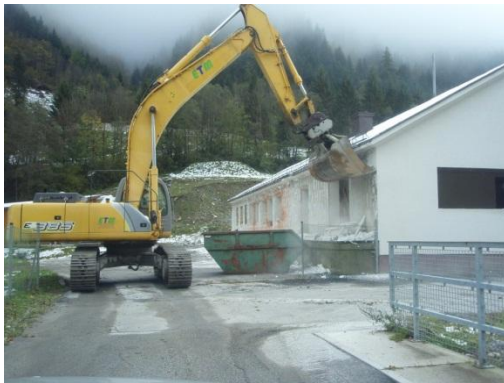
Abbildung 1: Abbruch altes Bürogebäude
