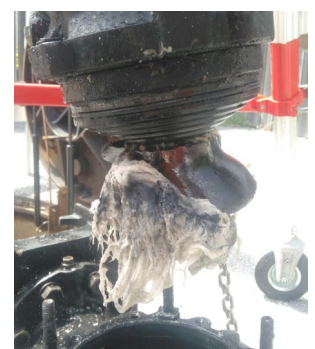
Bild oben u. rechts: Fetzen im Laufrad
